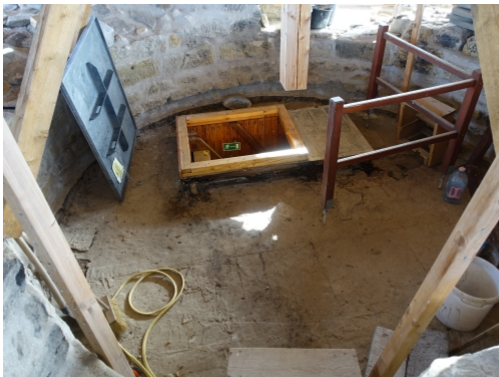
Foto z průběhu rekonstrukce horního podlaží hradní věže – sejmutý podlahový rošt (9/19)
